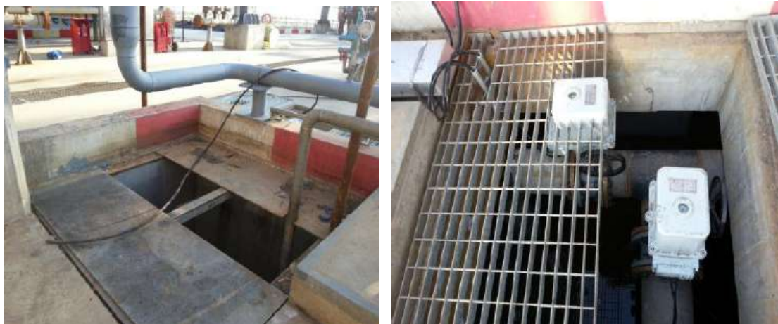
图 2.2-3 码头围污坎及污水泵
