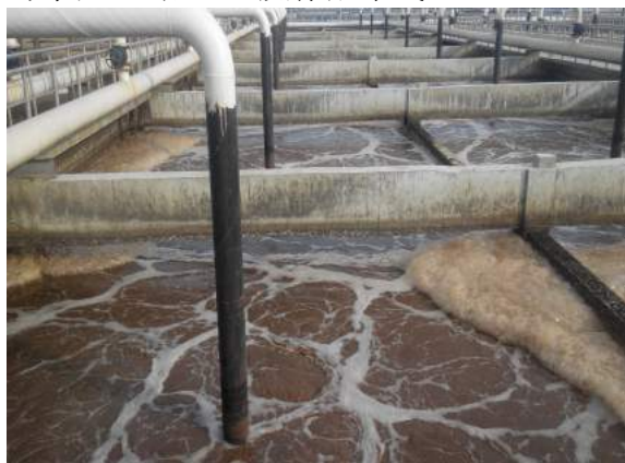
污水处理站（二级射流曝气池）
