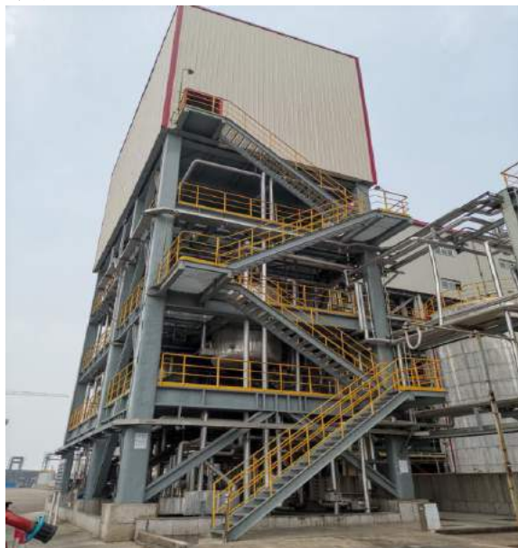
污水处理站（二级射流曝气池）
