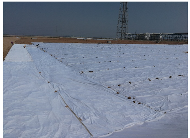
2017年5月事故灰场施工
