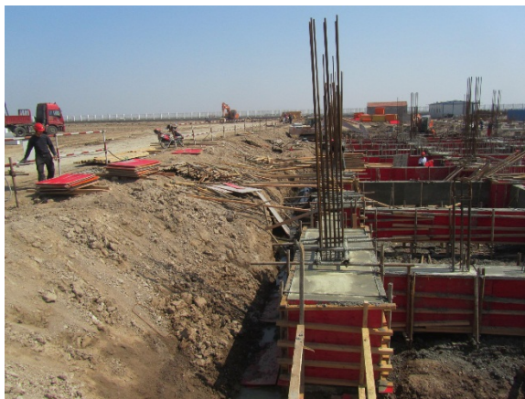
2013年4月26日 基坑开挖
