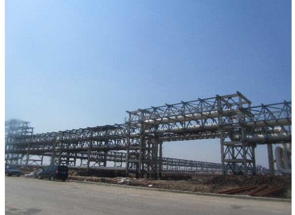
2014年3月 供热管网开始施工
