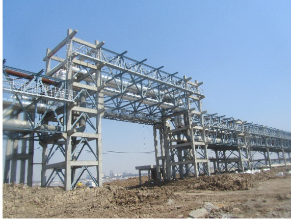
2014年3月 供热管网开始施工
